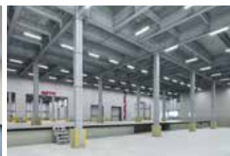
トラックバース庫内(1階)
